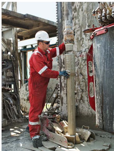
Bohranlage Erdpress, Österreich
